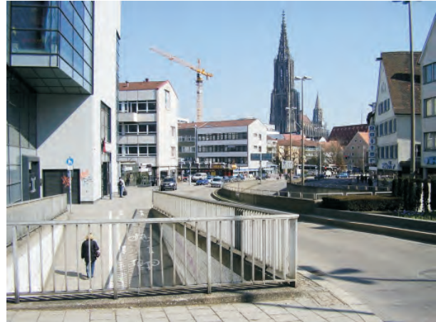
Abb. 79: Neue Straße, Unterführung
