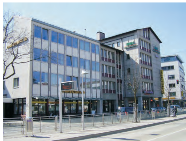
Abb. 82: Neue Straße, Südseite
