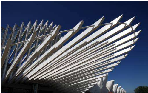
... Der HS Bahnhof in Reggio Emilia . . . . . Projekt von Calatrava , Detail des Eingangsdachs
