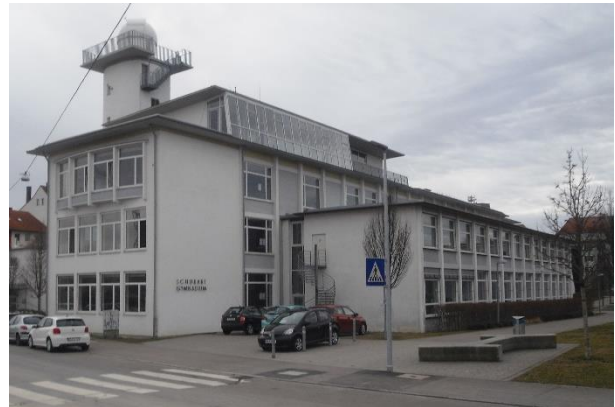
Innere Wallstraße 30 (Schule), Ansicht West
