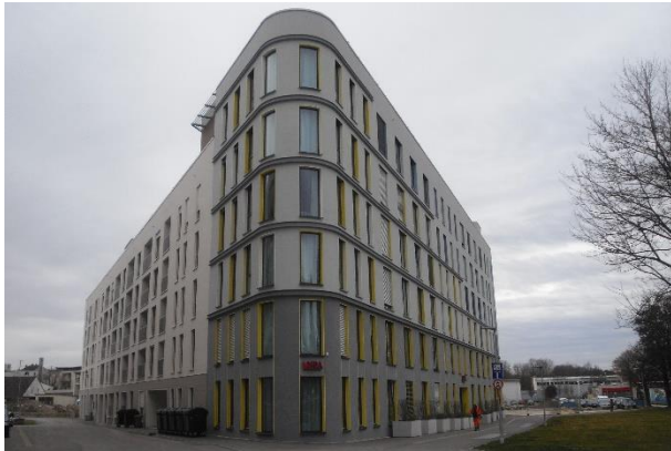
Kleiststraße 33, Ansicht West (rechts im Bild)
