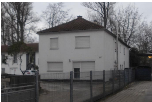
Bleichstraße 30/2, Ansicht Süd/Ost
