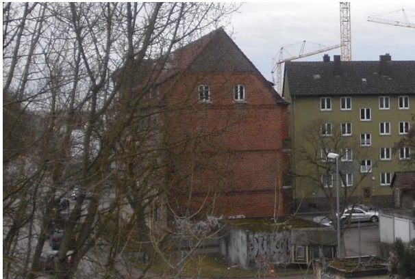
Schillerstraße 55, Ansicht Nord
