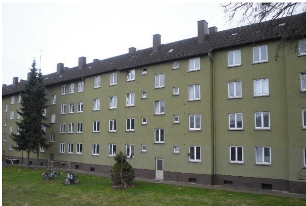
Mörikestraße 8, Ansicht Nord
