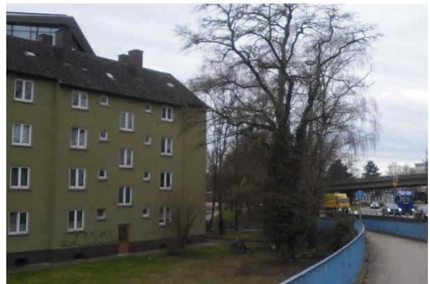
Mörikestraße 12, Ansicht Nord
