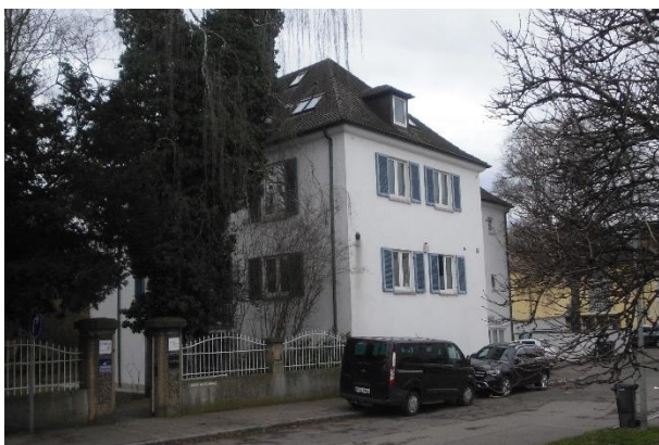
Hindenburgring 31, Ansicht Ost/Nord
